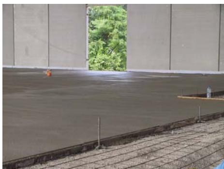
pavimentazione con ridotto numero di giunti
