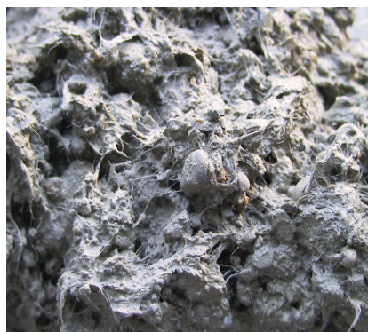
fiberbeton allo stato fresco
