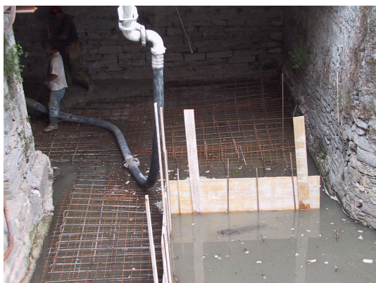
Darsena, getto subacqueo in presenza di acqua corrente
