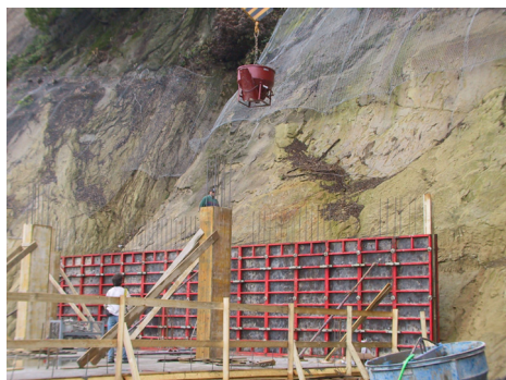
muro impermeabile contro terra
