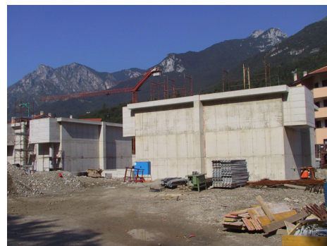
vasca impermeabile ad elevata durabilità
