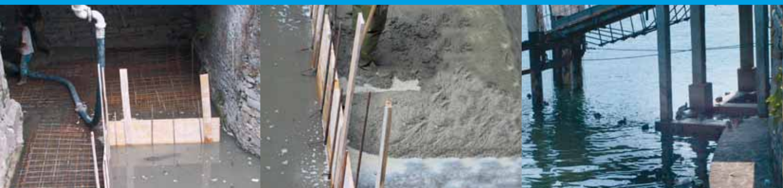
Darsena, getto subacqueo in presenza di acqua corrente
