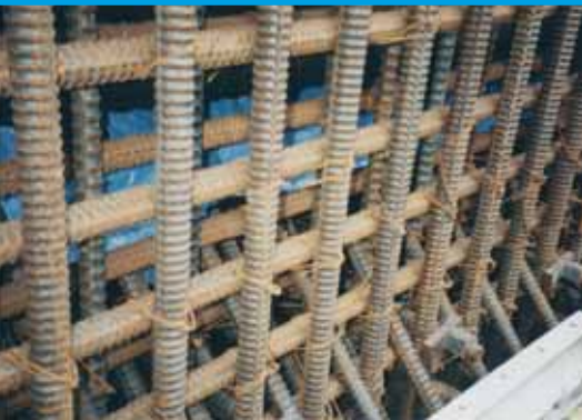
Struttura con alta densità di armature
